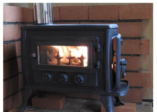
ブの設置と煙突をつないで屋根まで設置する。火入れして燃焼状況を確認、ストーブの中に空気が引っ張られて、良く燃えている。設置工事成功でした。これで、キャビンに暖房が入りましたので、3月から12月まで使用できます。次回ワークキャンプ12月には杉板を壁に貼るので、居住性、見た目も良くなります。
